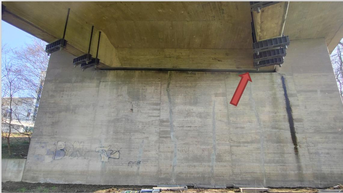
Abbildung 2: Lage des stationären Erfassungsgerätes in der deutlich engeren Spalte unterhalb der Fahrbahn der B6 am südlichen Widerlager der Leinebrücke in Neustadt a. Rbge.
